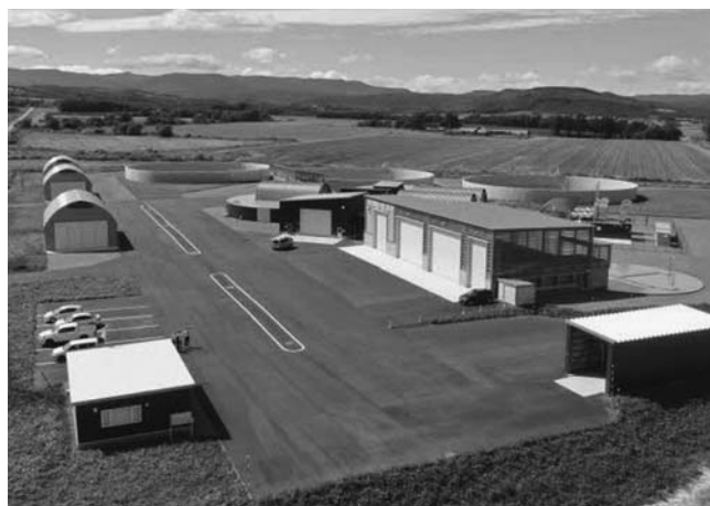
▲ バイオガスプラント敷地内の事務所に設置
